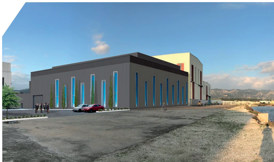
Vue d'architecte de la nouvelle salle blanche en cours de construction en 2020.
